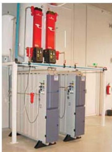
Установка устройств MAXIGAS
